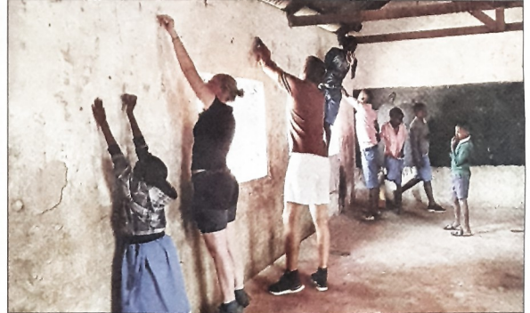
Gemeinsam mit Eltern und einigen älteren Schülerinnen und Schülern erhielt die gesamte Schule von außen und mehrere Klassenräume von innen einen neuen Anstrich.
