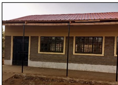
Der neue Klassenraum an der Kyaani Secondary School
