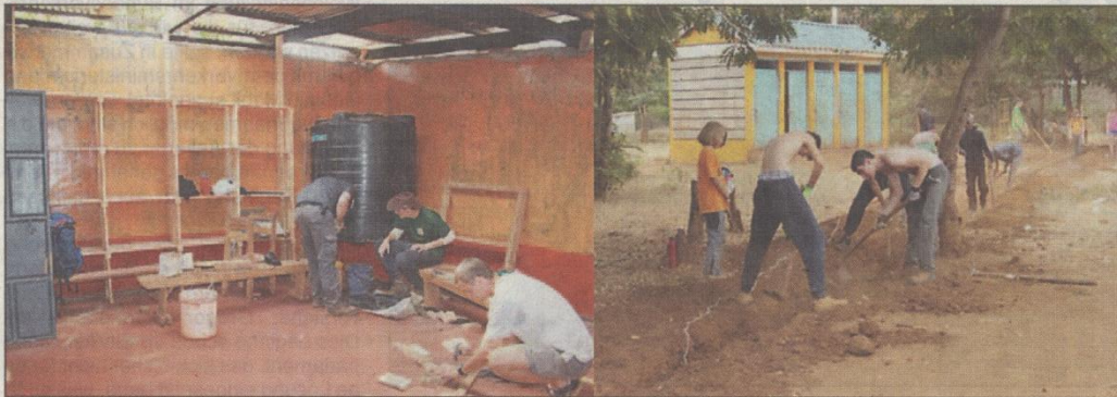
Das Foto zeigt den neuen Anbau mit selbstgezimmerter Regale und einem Trinkwassertank sowie die Verlegung einer Wasserleitung.
